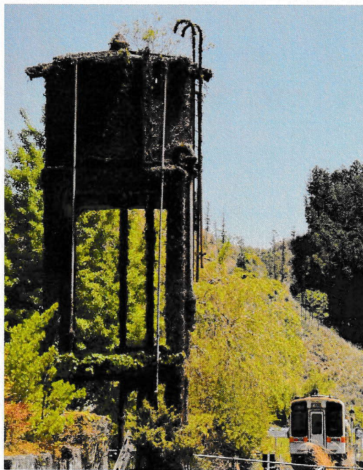
現存する蒸気機関車の鉄製タンクの給水塔は、登録有形文化財では全国で鳥取県の若桜(わかさ)鉄道若桜駅と伊勢奥津駅の2基。
